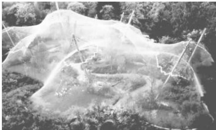
Certes, cet exemple est gigantesque et lourd : plusieurs milliers de mètres carrés de surface couverts, des ancrages en béton, des mâts et des câbles en acier... Mais l'idée est intéressante et facile à transposer à échelle plus modeste, ce qui réduit les contraintes physiques et permet l'emploi de matériaux naturels : mâts en bambous ou taillés dans des troncs, lianes ou cordes en guise de câbles, etc.
